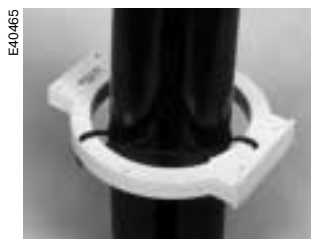
Монтаж на кабелях среднего напряжения
